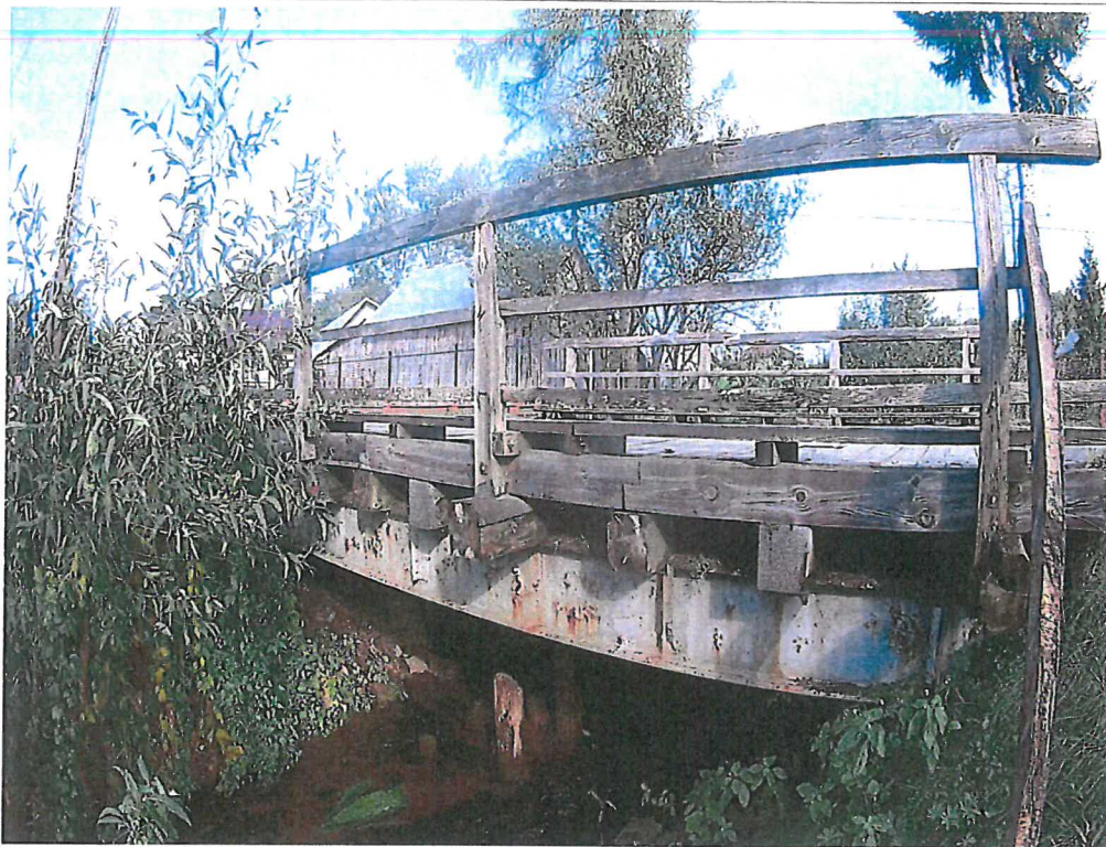
Fot. 3. Widok boczny na obiekt
