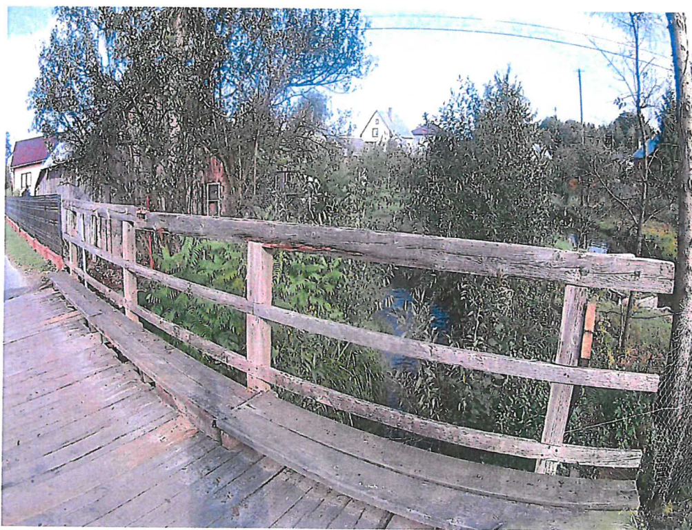
Fot. 2. Widok na barierę dla pieszych
