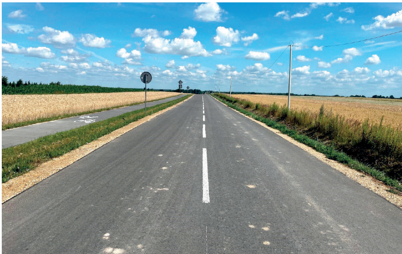
♦ Przebudowana droga Stary Dzików - PGR Stary Dzików wraz chodnikami i ścieżką rowerową
