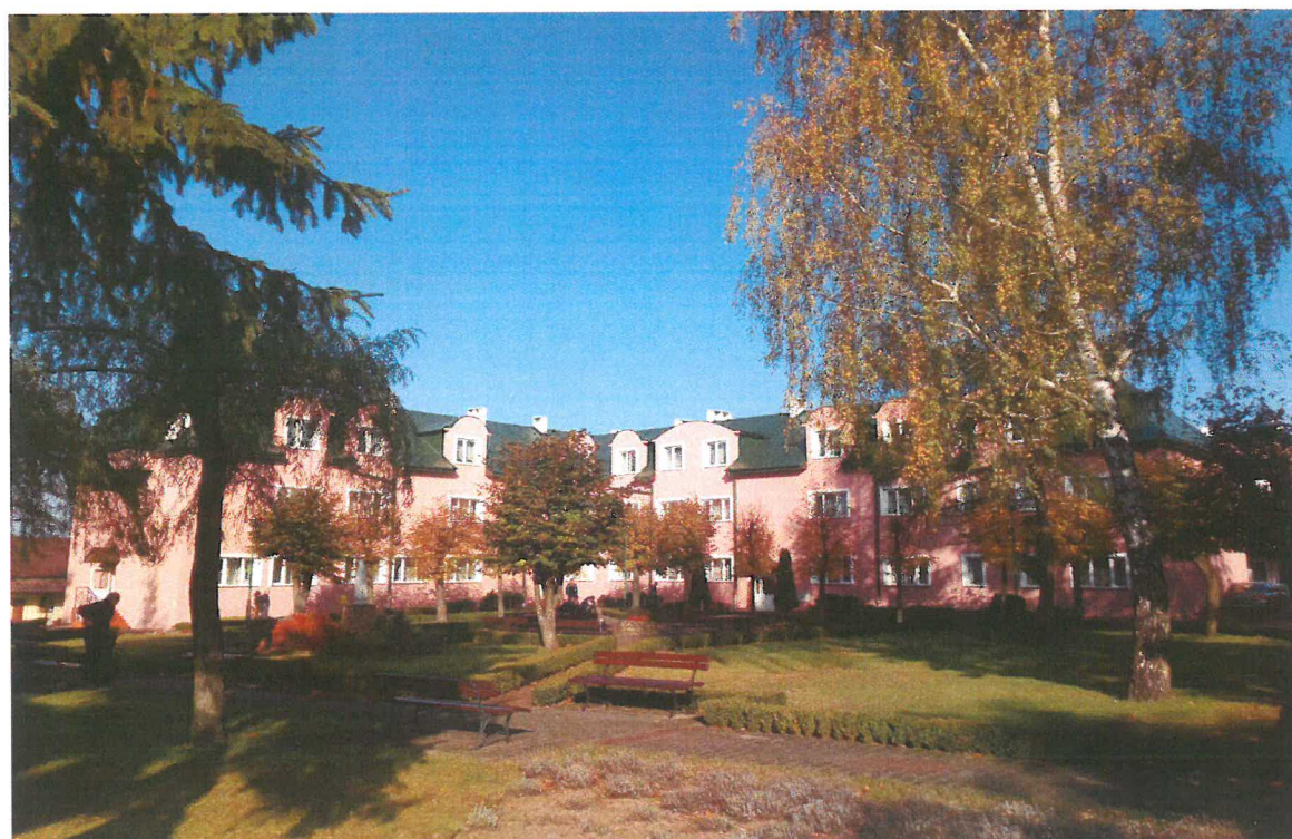
Budynek Oddziału II
